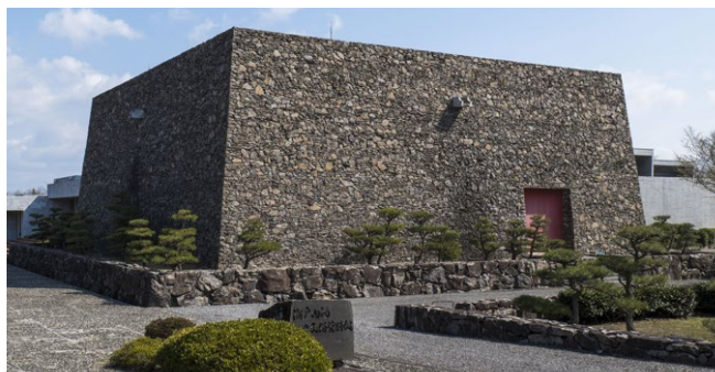
建物の石積みの外観
