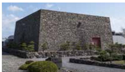
建物の石積みの外観
