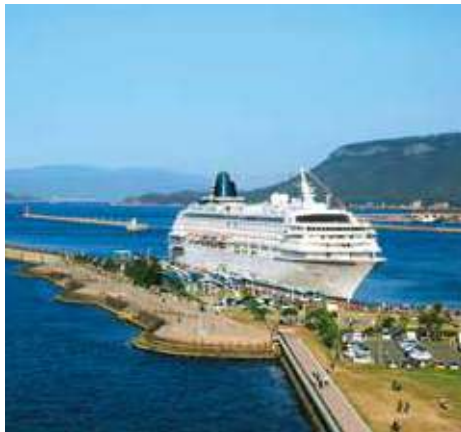
5万吨級岸壁 5만 톤급 안벽 Wharf for 50,000-ton Class Ships 5万吨级泊位
